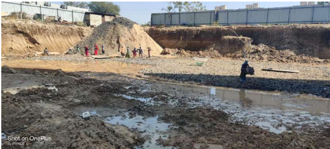
Fig. 4.1 Rubble Soiling
