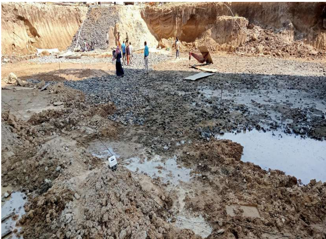
Fig: 4.1 Rubble laying
