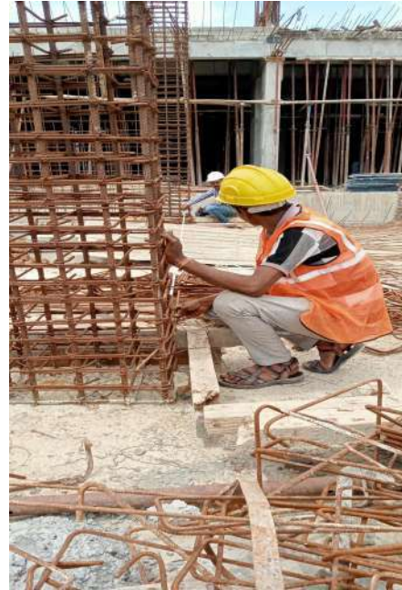
Fig: 10.4 Starter checking
