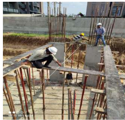
Fig: 8.2 Beam Bottom Checking
