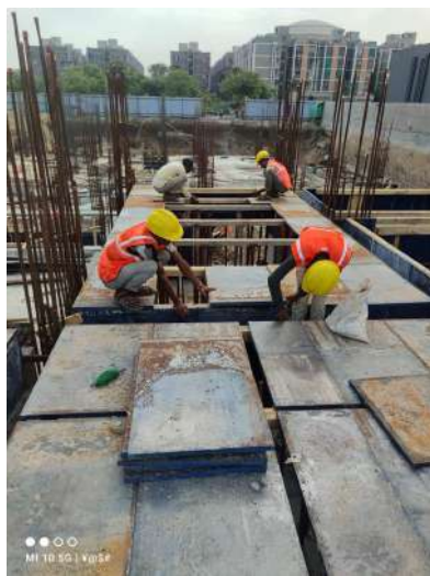
Fig:8.4 Slab Centering
