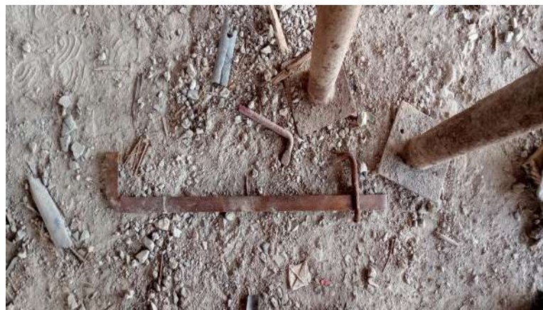
Fig: 13.6 Shuttering Clamp
