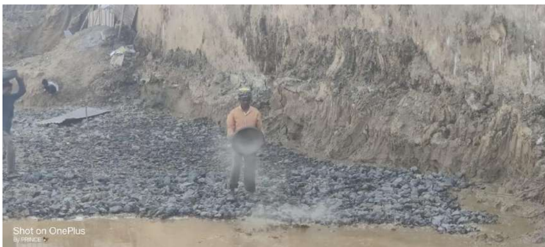
Fig. 4.2 Rubble Soiling
